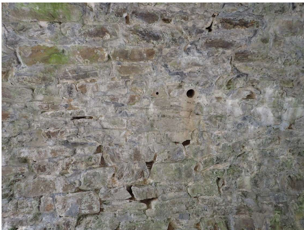
Foto 4: Vypadané spárování mezi kameny, stopy po diagnostickém vrtu
