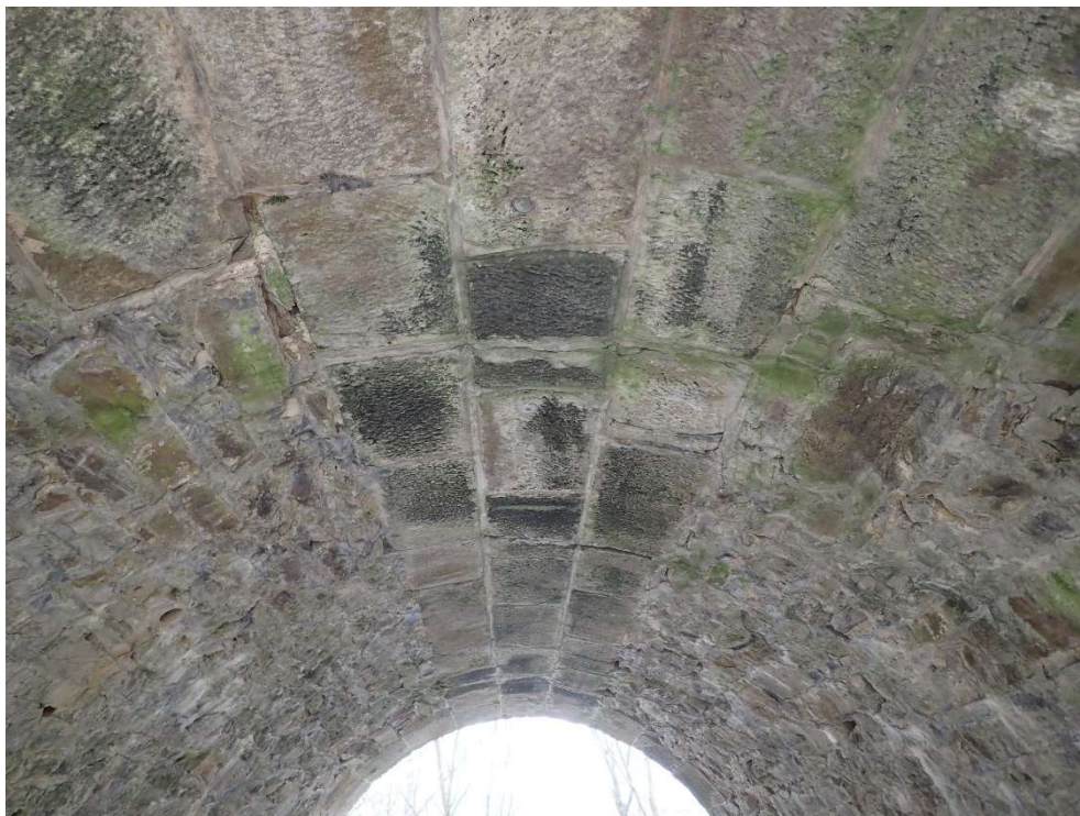
Foto 3: Trhliny v klenbě, průsaky, vypadané spárování
