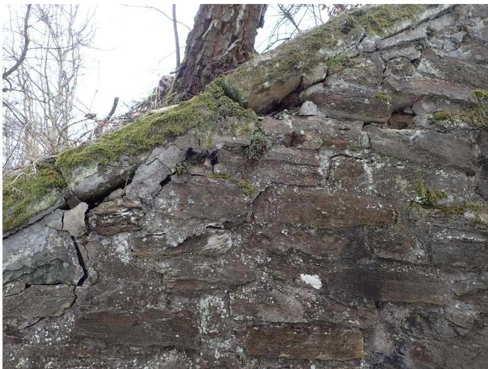
Foto 5: Degradace kamene na římsách křídel
