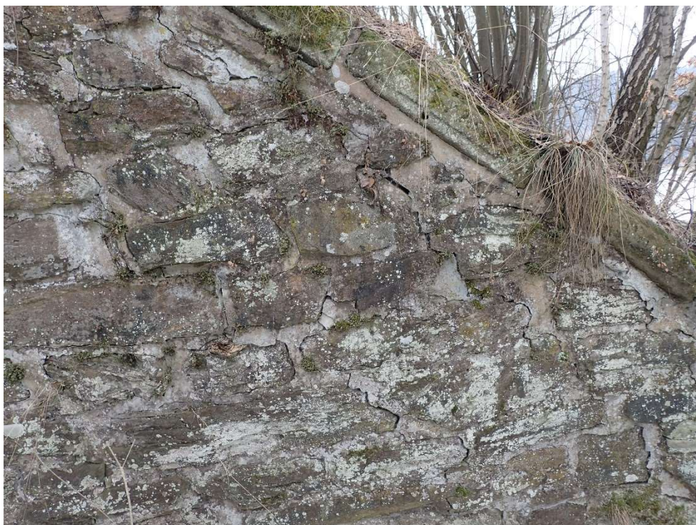
Foto 6: Uvolněné a vypadané spárování, prorůstající vegetace
